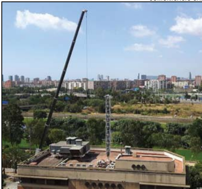
Moment del desmantellament de l'antena de telefonia de l'edifici de Telefónica, al Passeig de la Rambleta.
