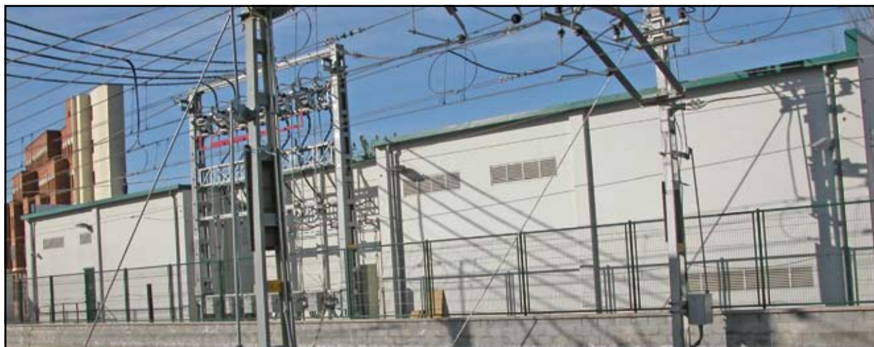
Adif contrueix una nova subestació elèctrica a Sant Adrià.
