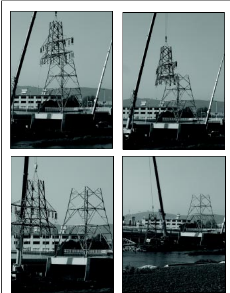
Después de que los operarios soldasen las patas metálicas de la torre más cercana al arco de Sant Adrià y dividirla así en tres partes, la grúa que sujetaba el armazón de más de 40 metros de altura retiró la segunda de ellas dejando libre, al fin, el cielo adrianense.
