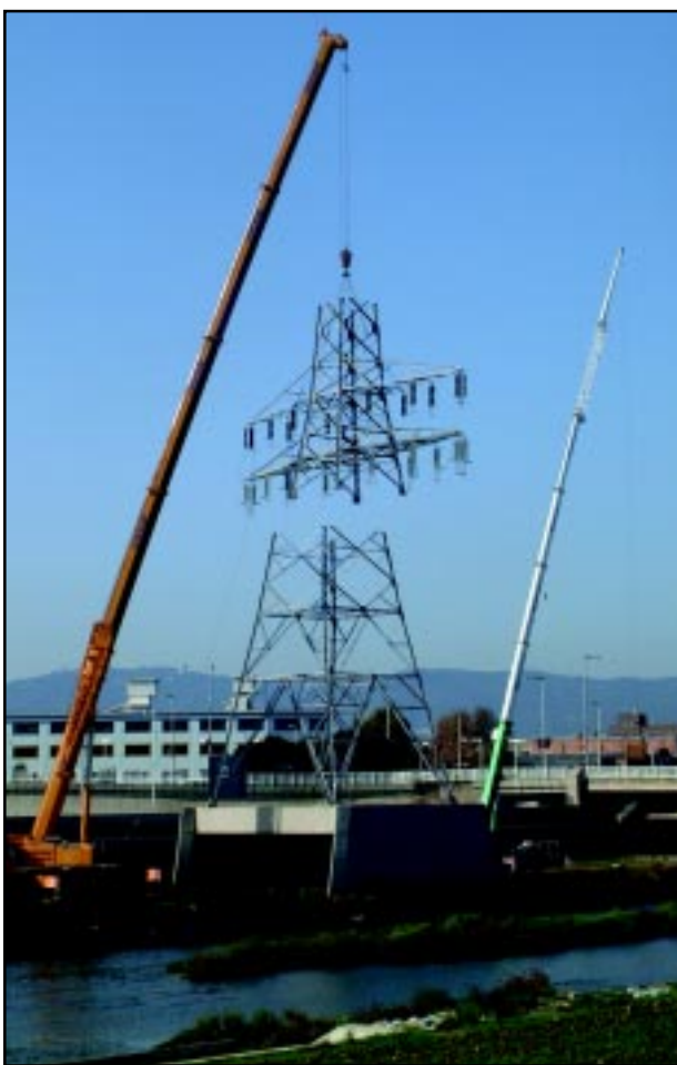
Dos grandes grúas se encargaron de desmontar la torre de alta tensión más cercana al arco de entrada a Sant Adrià. MS
