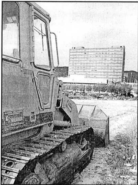
El entorno del hospital está lleno de obras actualmente. Foto: PULIDO
