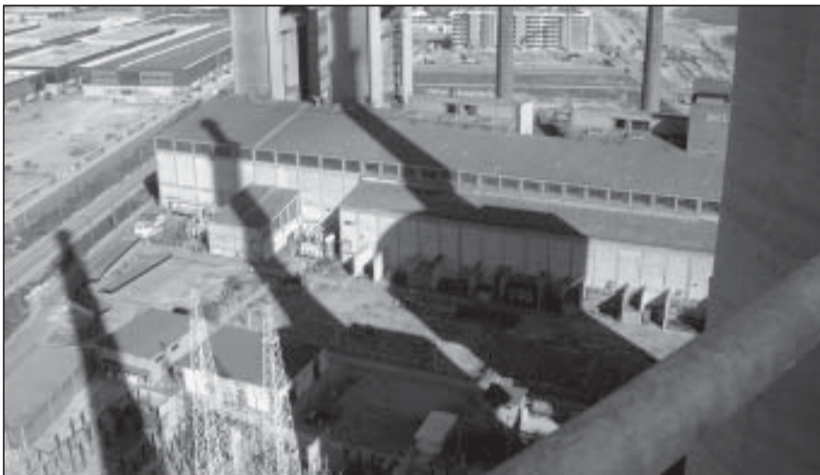
El futuro de las chimenas está en el aire.
