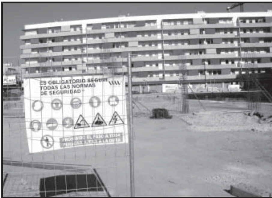
Ja han començat les obres de l'escola bressol pública als terrenys de Can Baurier. MS
